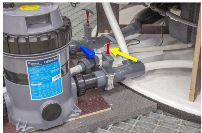
Auki asento. Siihen pystyy myös laittamaan "lukituksen" joka pitää venttiilin auki.
