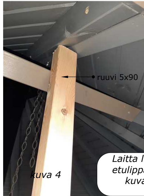
Etulippan poikkituki nro 20 kiinnitus ruuvi 5x90 2 kpl per liittos kuva 1
