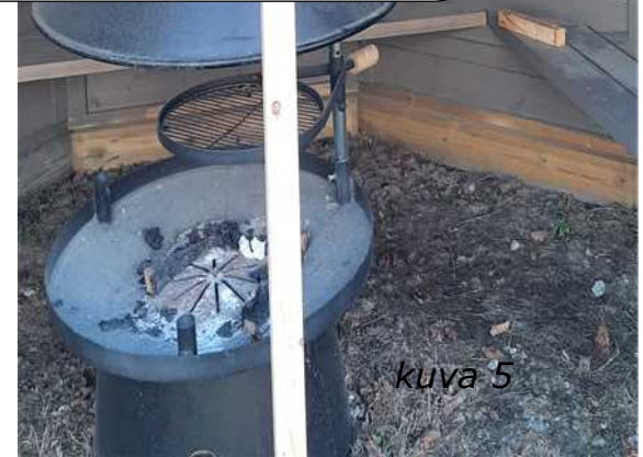
Laitta lumikuorman varoiksi paikallan etulippan talvituki nro 21 ruuvi 5x90 kuva 4 ja kuva 5
