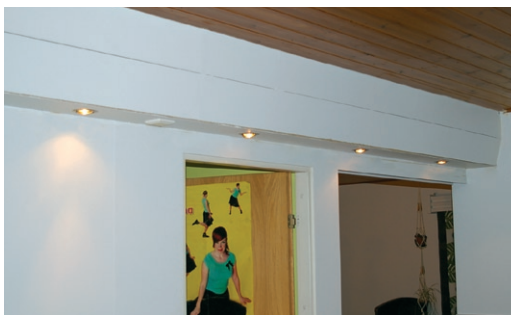
Kotelot valmiina ja eteisen lisävalaistus asennettuna.
