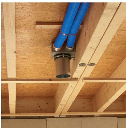
Kanavat liitettyä venttiiliyhteeseen
