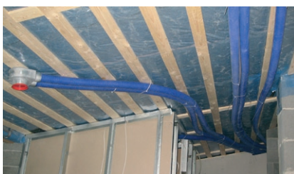
Asennus höyrysulun alapuolelle
