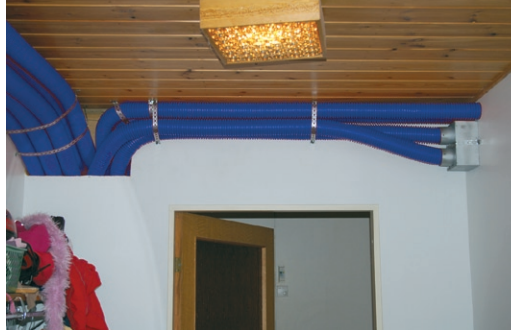
Kanavat asennettuna ennen kotelointia.
