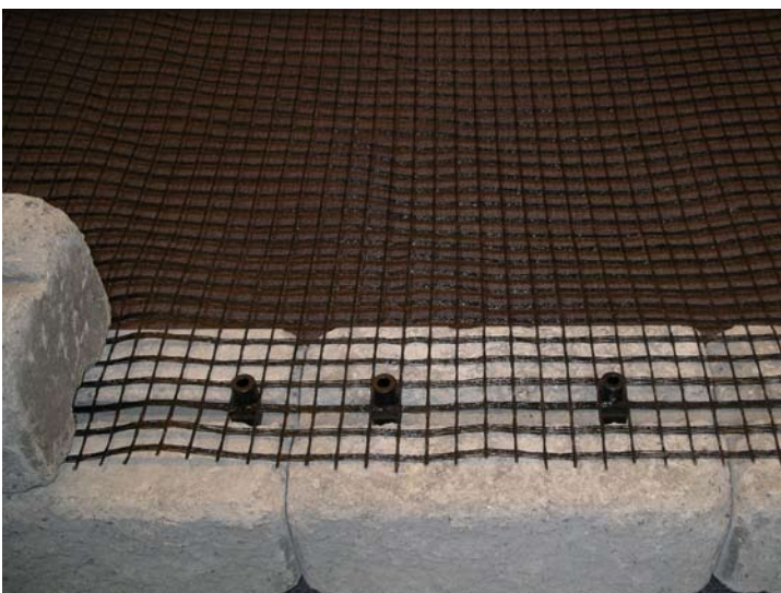
Kuva 4. Bendersin geoverkon asennus ensimmäiseen kerrokseen. Asenna verkko lukitusholkkien ylitse kuvan mukaisesti. Asenna verkko siten, että lukitusholkit tulevat läpi kolmannesta välistä. Tällä tavalla saat parhaan lopputuloksen.
