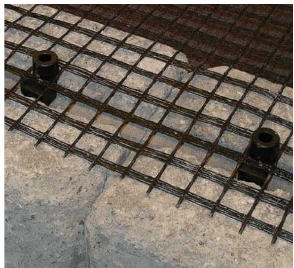
Kuva 4. Bendersin geoverkon asennus ensimmäiseen kerrokseen. Asenna verkko lukitusholkkien ylitse kuvan mukaisesti. Asenna verkko siten, että lukitusholkit tulevat läpi kolmannesta välistä. Tällä tavalla saat parhaan lopputuloksen.
